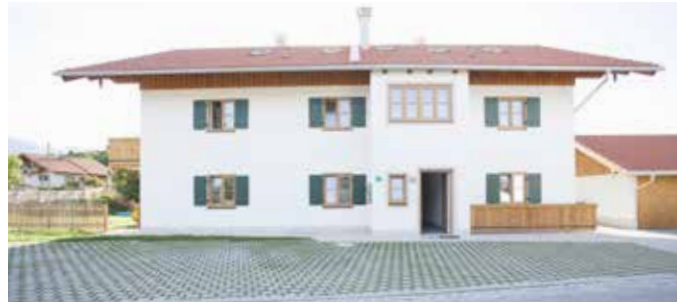
Komplette Pflaster- und Vegetationsarbeiten Bauherr: Gemeinde Gaißach
