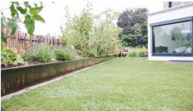
Mauer mit Cortenstahlverblendung und Pflanzbeet
