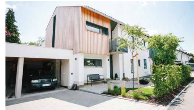
Garageneinfahrt mit Zugang zur Haustüre
