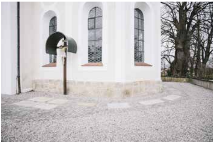
Katholische Kirche Unterdarching, Pflasterarbeiten Planung: Theo Keller
